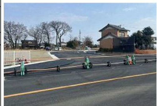
①現況写真
