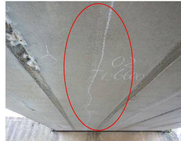
コンクリートの劣化（野府川）
