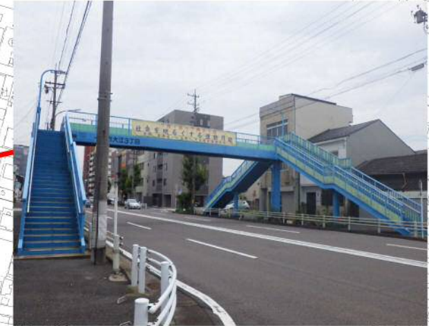
落橋防止の設置（耐震補強）
