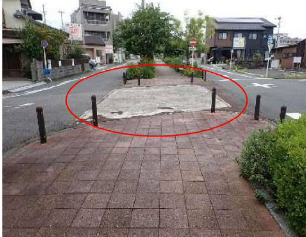
【補修工事】旧市25号橋
