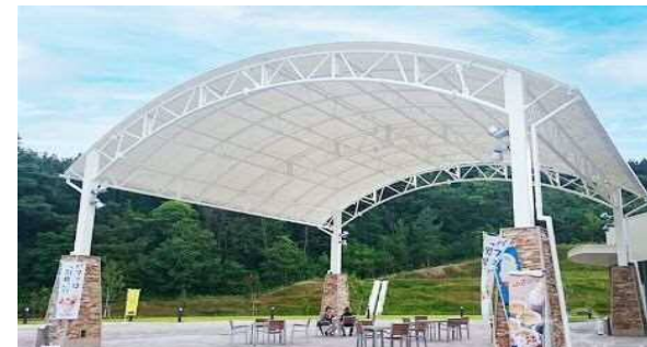
例 大屋根施設
