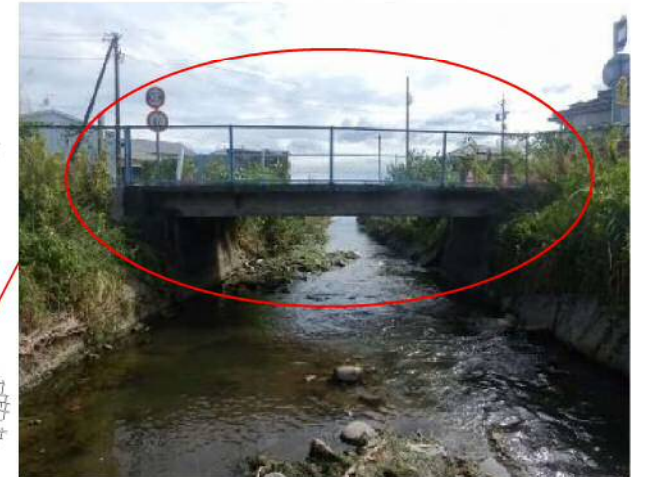
【補修工事】無名橋
