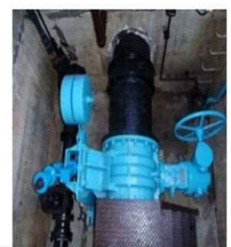
【緊急遮断弁設置イメージ】
